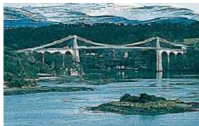
el puente bridge
