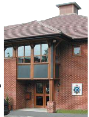
la estación de policía police station
