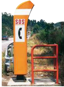
el teléfono de emergencia emergency phone
